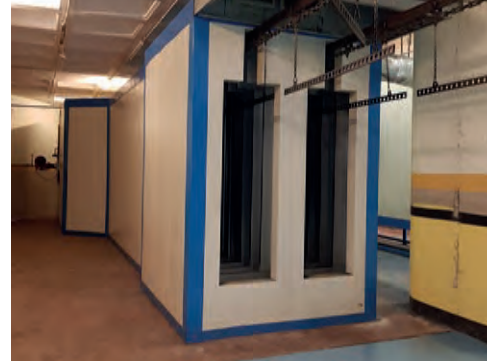
3 - Fırınlama Boya pişirme işlemi
